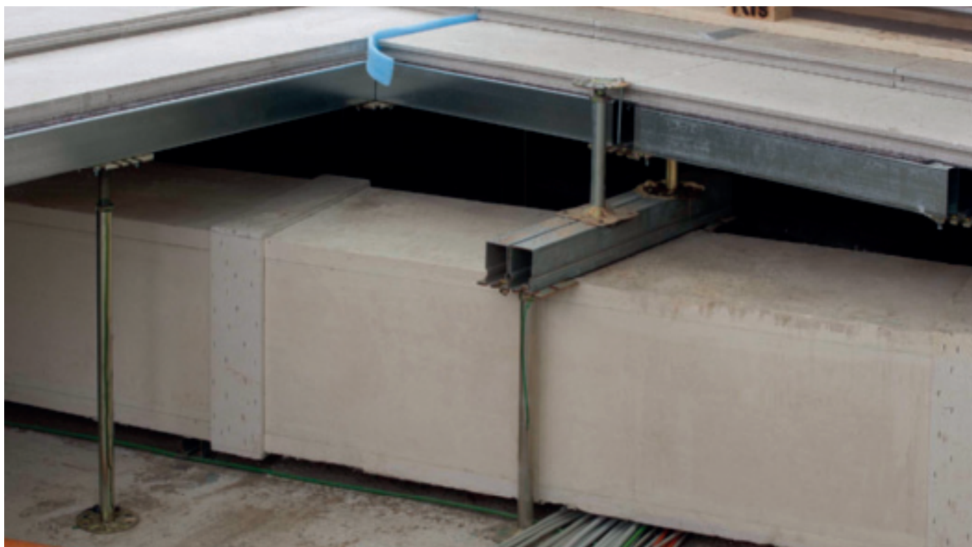
Der GIFAFloor FHB plus wurde für die Schwerlastanforderungen zweilagig aufgebaut. Darunter konnten die bereits vorhandenen Leitungen beibehalten werden.
