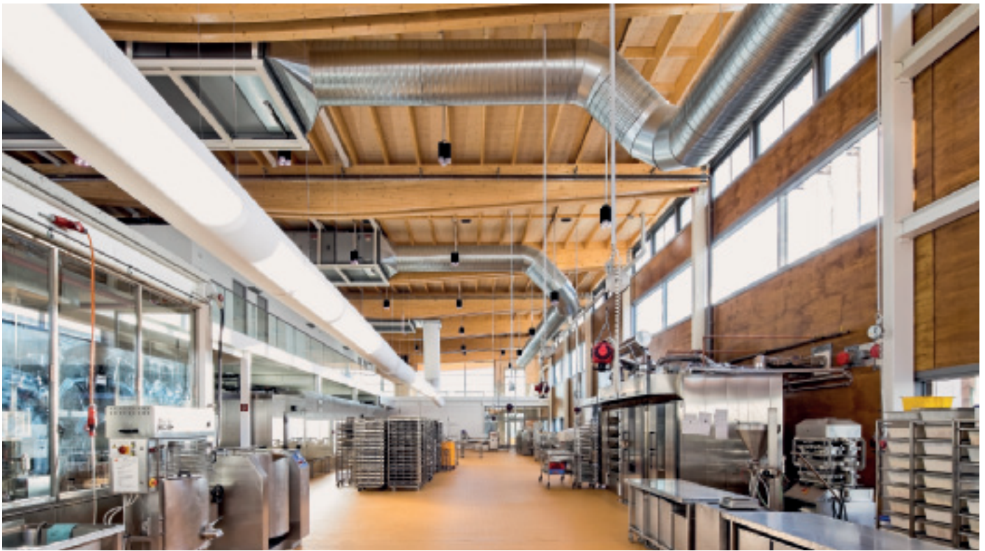
Auch der Estrichbeschleuniger musste baubiologisch unbedenklich sein.
