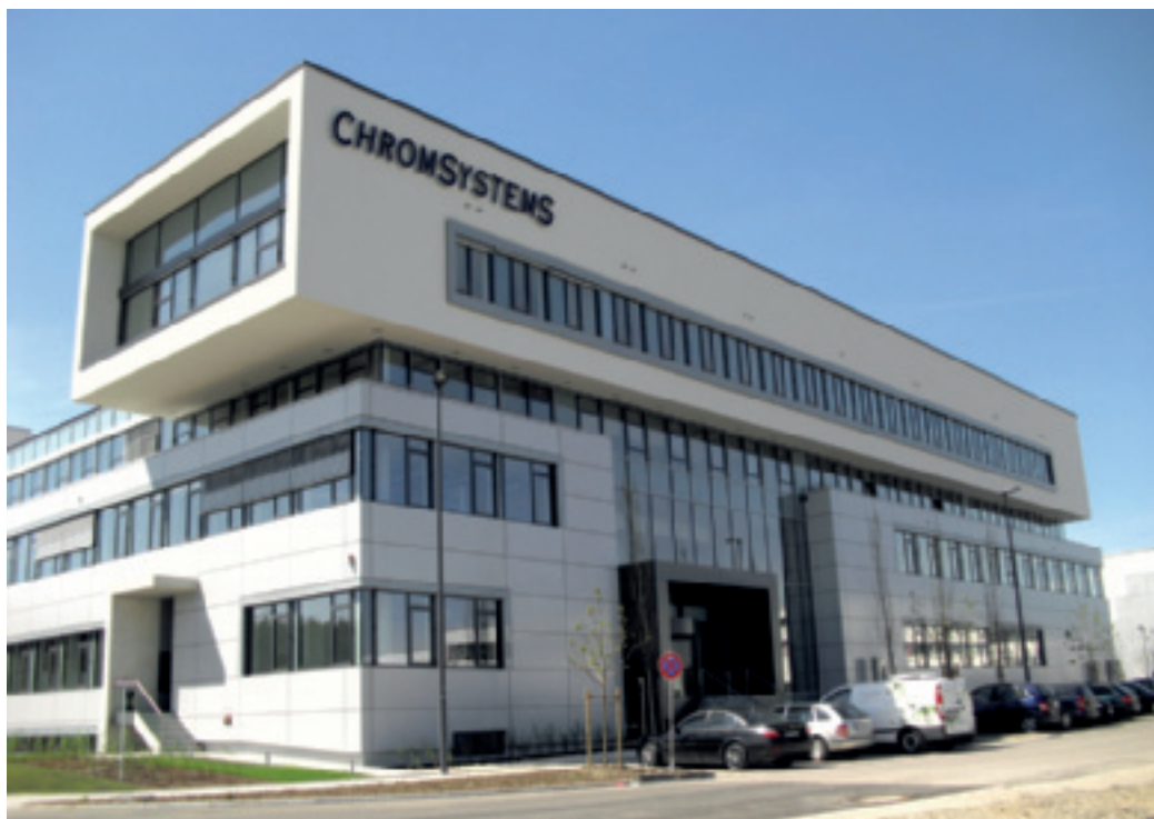
Auch bei Chromsystems haben die PCT-Techniker den Estrich einbau begleitet.
